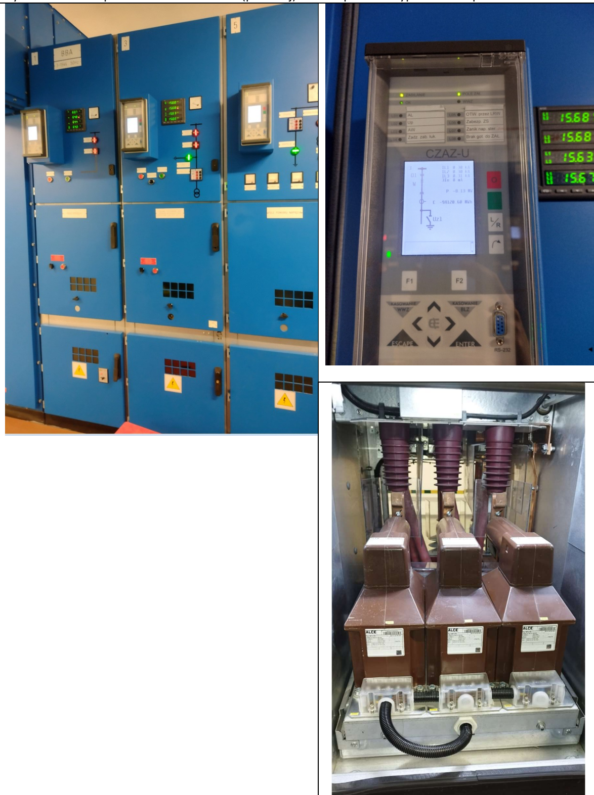
Rys. nr 19 Widok pola nr 3 w rozdzielni SN (po lewej) oraz zespołu EAZ typu CZAZ-U i przekładników.
