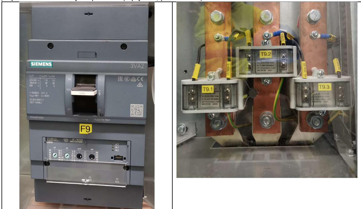
Rys. nr 15 Widok wnętrza pola nr 9 (wyłącznik, przekładniki).
