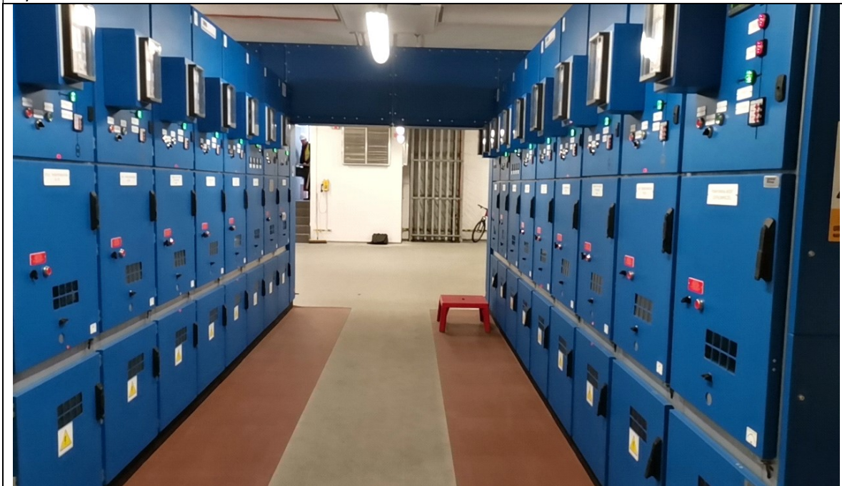
Rys. nr 18 Widok rozdzielni SN.
