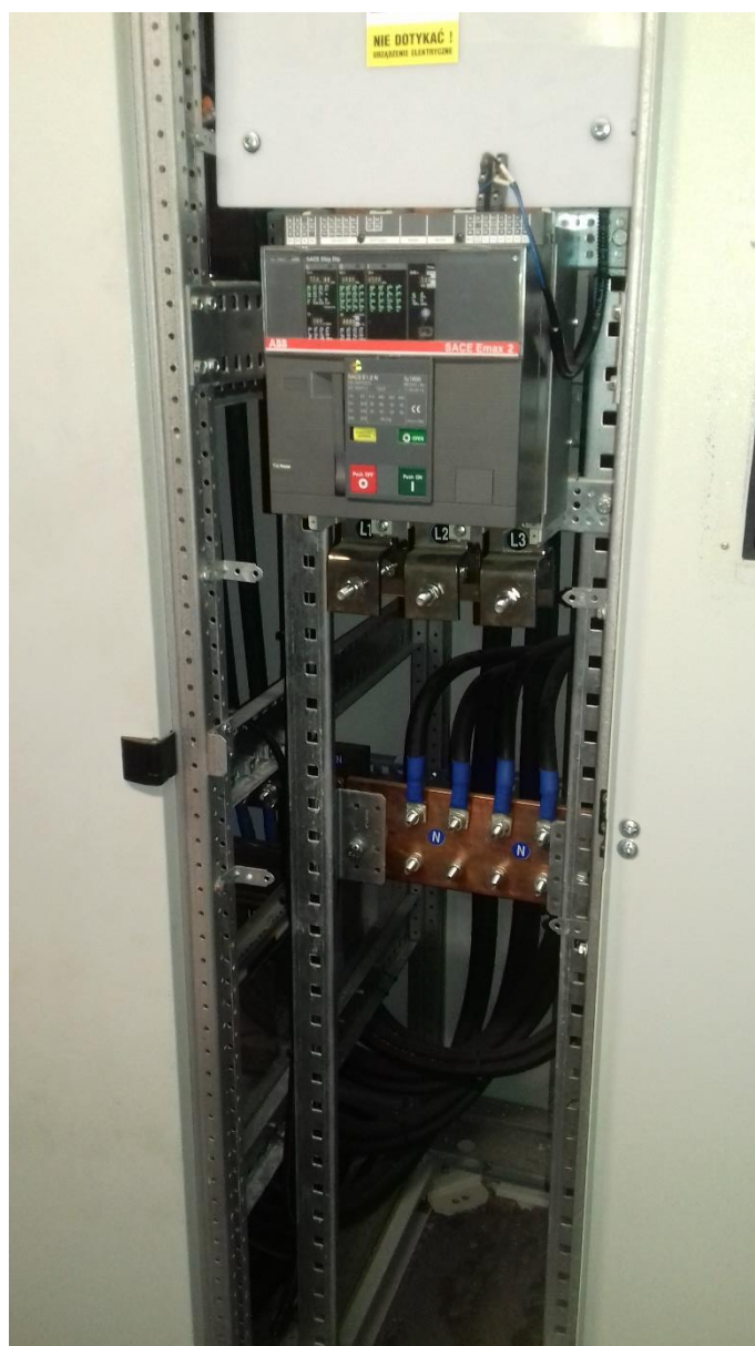
Rys. 2 Pole podłączenia obciążnicy
