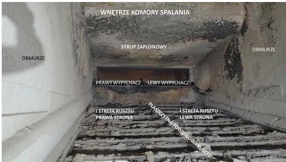
Rysunek 11. Wnętrze komory spalania
