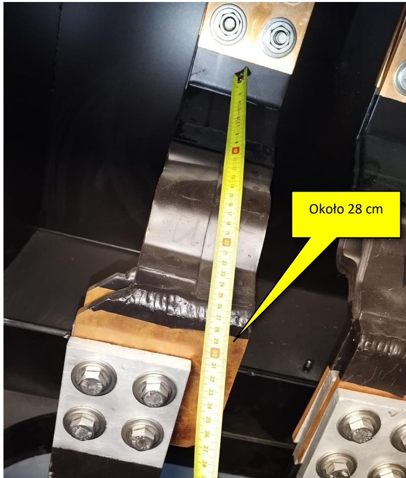
Rys. 8 Zdjęcie wnętrza skrzynki zaciskowej bocznej - wymiarowanie
