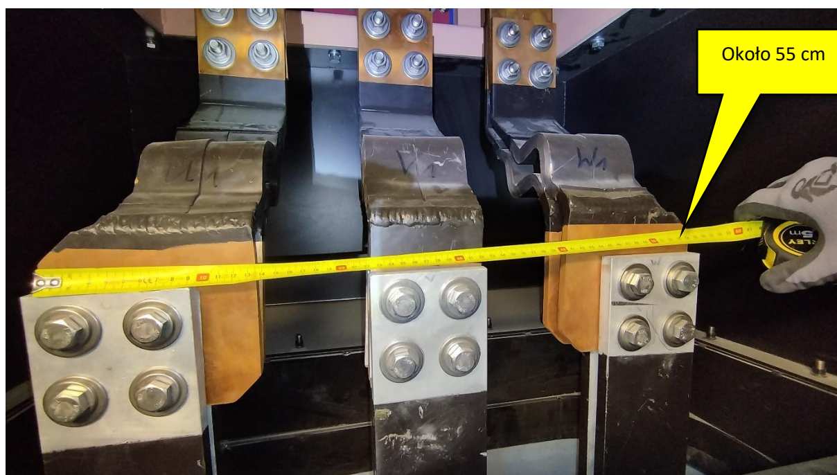
Rys. 7 Zdjęcie wnętrza skrzynki zaciskowej bocznej - wymiarowanie
